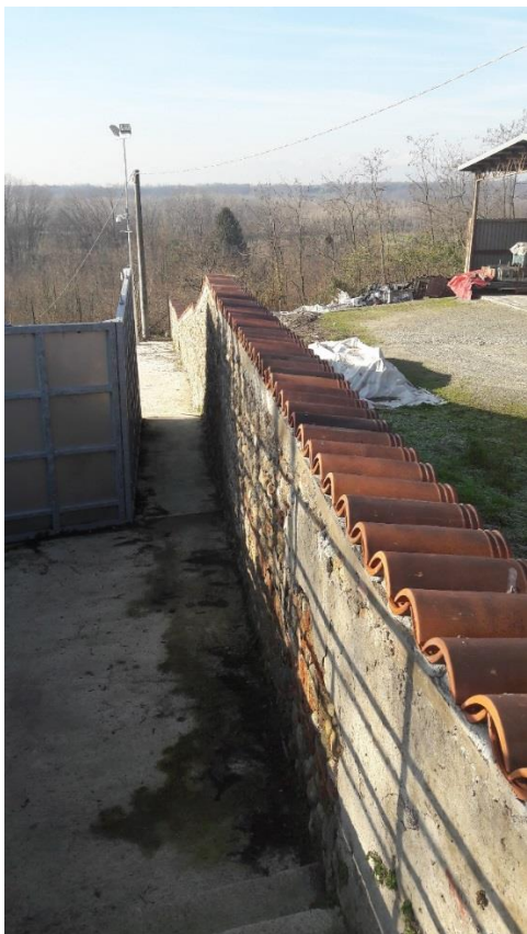
Centrale Rocca: ripristino muro
