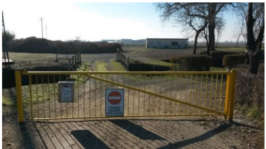
Nuova sbarra di accesso al ponte
