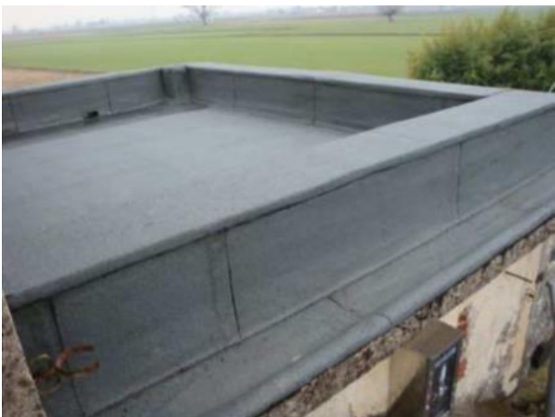
Impermeabilizzazione copertura
