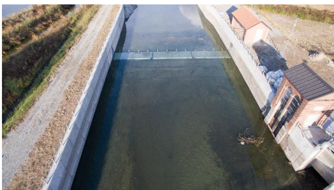
Nuovo imbocco Cavo Lucca – particolare modellatore idraulico
