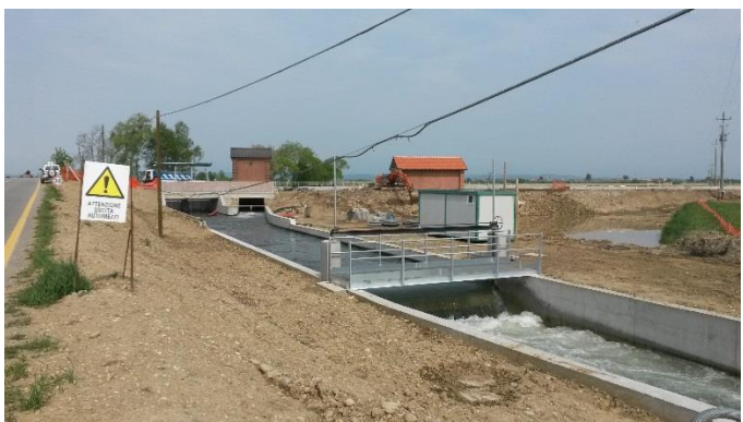
Nuovo imbocco Cavo Lucca – particolare modellatore idraulico
