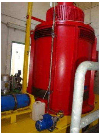
Supporto e pompa di circolazione
