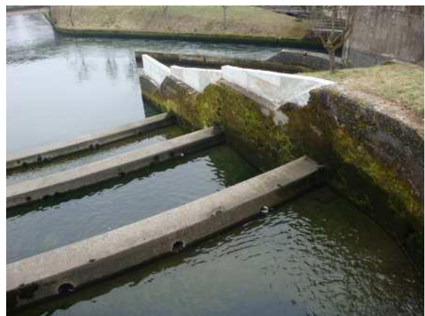
Sopraelevazione muro sponda
