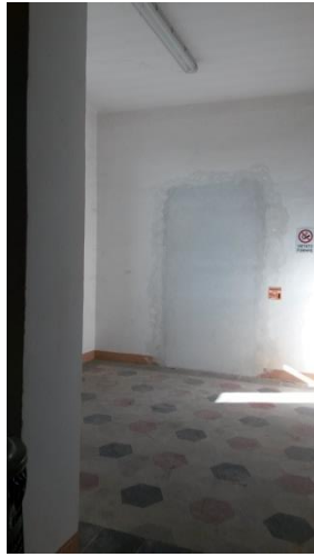
Ristrutturazione locali al primo piano
