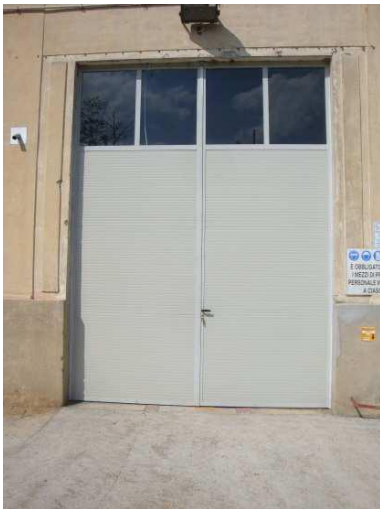
Nuovo ponte d'ingresso
