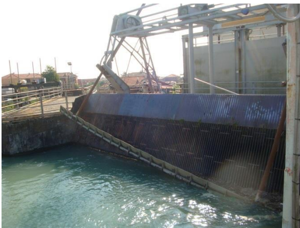
Sistema di sgrigliatura detriti
