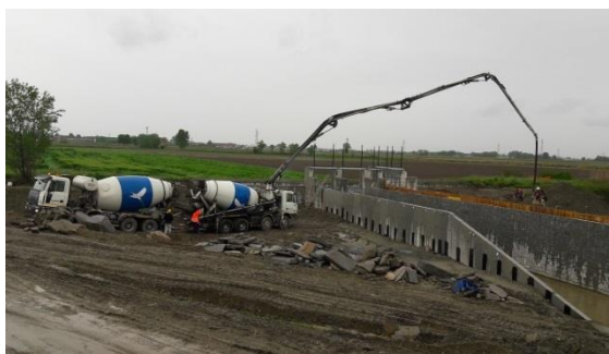
Prog. 304A – Getto muro sponda sinistra cavo Aiglio
