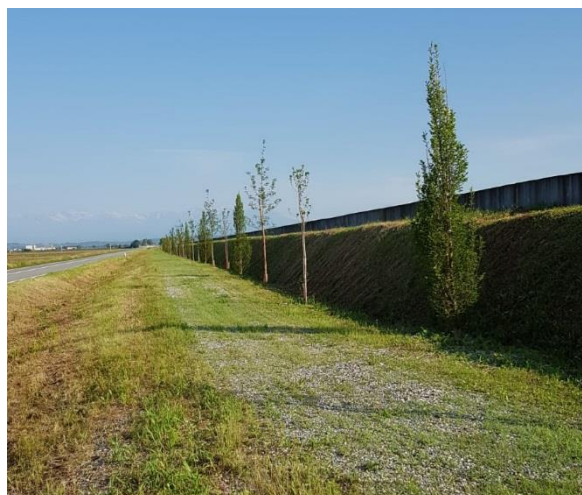
Prog. 140MBis – Piantumazioni in sponda destra cavo Lucca
