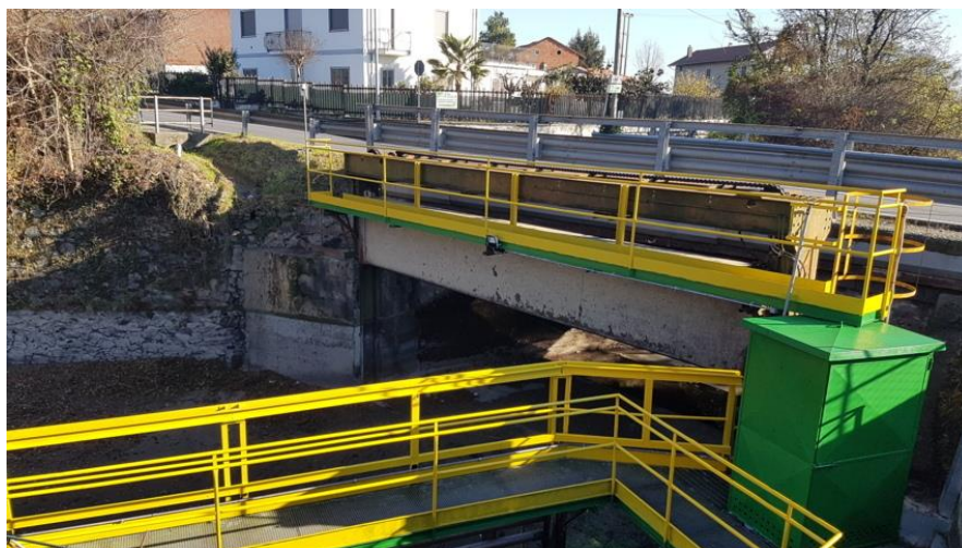
Situazione dopo l'intervento
