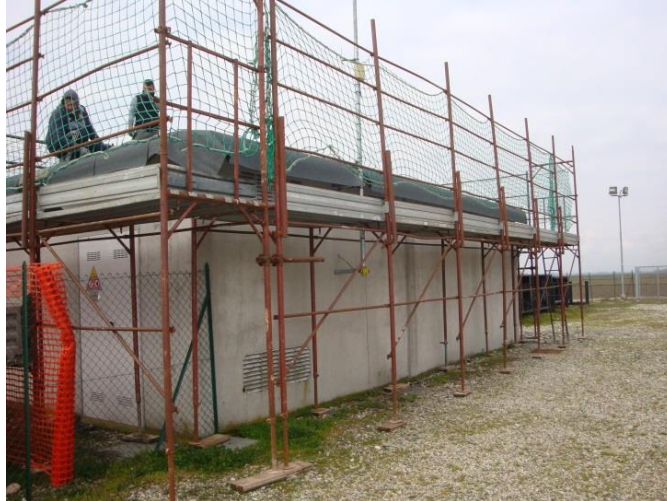
Lavori di impermeabilizzazione copertura locali tecnici
