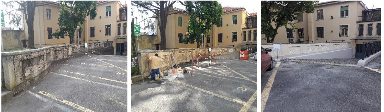
Sistemazione muretto giardino Palazzo Pasta
