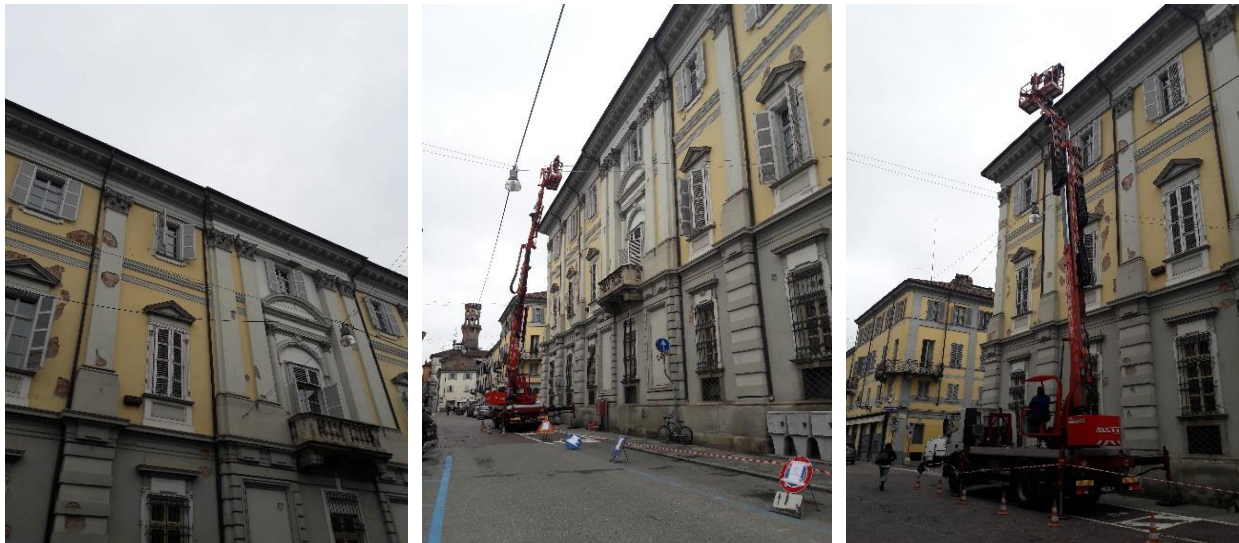
Sistemazione facciata via Gioberti Palazzo Pasta
