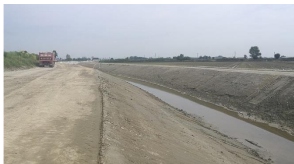
Prog. 304A – Nuovo Scolmatore
