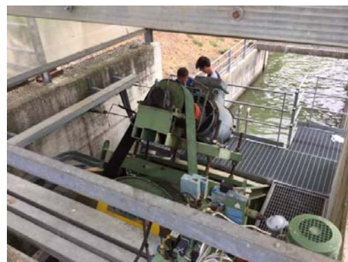
Scambiatore al piano interrato
