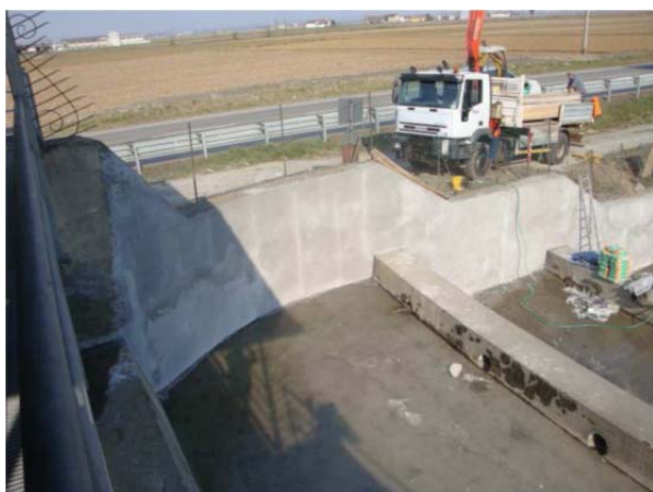
Impermeabilizzazione muro
