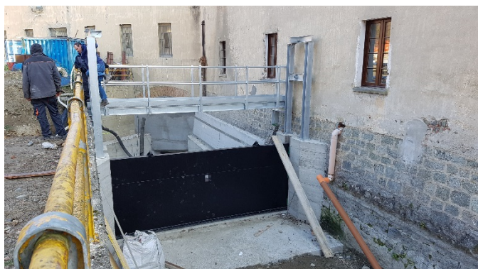
Posa pancone canale di scarico
