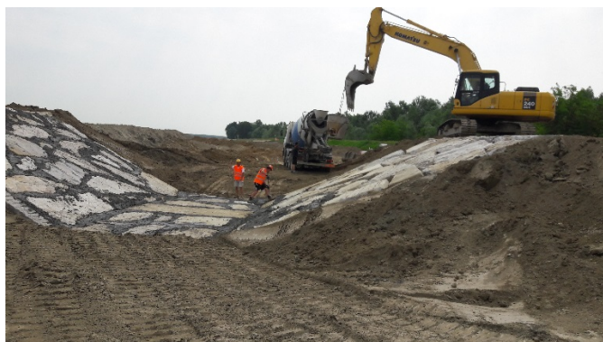
Realizzazione scogliera intasata a protezione del nuovo sifone
