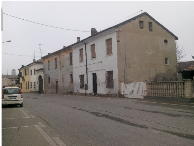
Casello di Pezzana: ripristino intonaco
