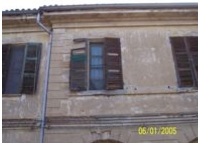
Mulino di Salasco: sostituzione persiane fatiscenti
