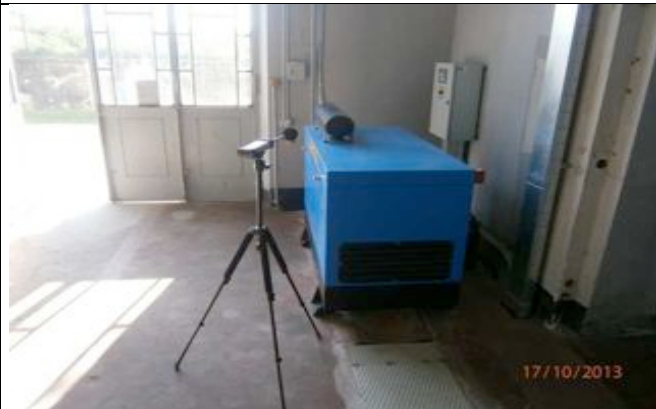
Misura del rumore presso la Centrale Petiva
