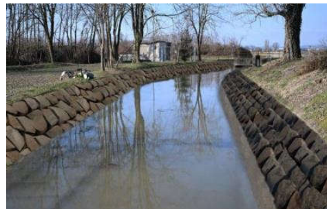
Naviletto di Asigliano rivestimento spondale in muri in c.a., scogliere in massi e nuovo barraggio Volto
