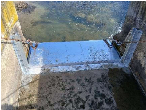
1. Barraggio Baconcio e barraggio Roggia Molinara entrambi in comune di Desana sostituzione paratoie € 19.700
