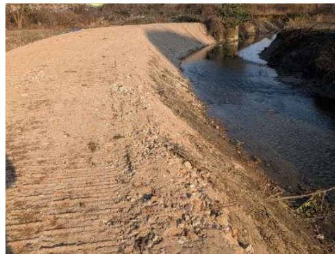
2. Scaricatore Provana in Provalina in comune di Vercelli Sboscamento e riprofilatura sponda sx con riciclato per ml. 200 € 21.500
