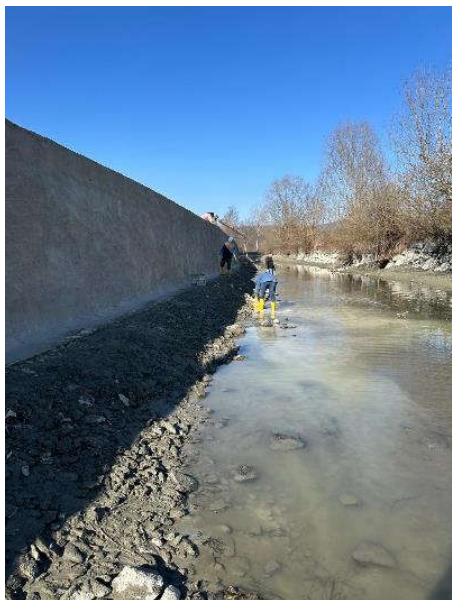
5. Impermeabilizzazione di tratto sponda DX del Naviglio d'Ivrea, in prossimità del bocchetto Riasco, per m. 50.00 - € 5.000
