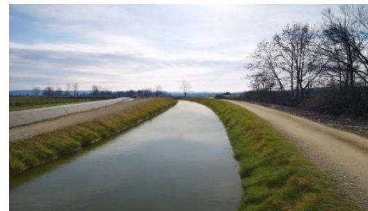
Canale Magrelli a valle SP32, Nuovo Scolmatore e strada per Pobietto
