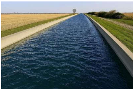
Naviletto di Asigliano rivestimento spondale in muri in c.a., scogliere in massi e nuovo barraggio Volto
