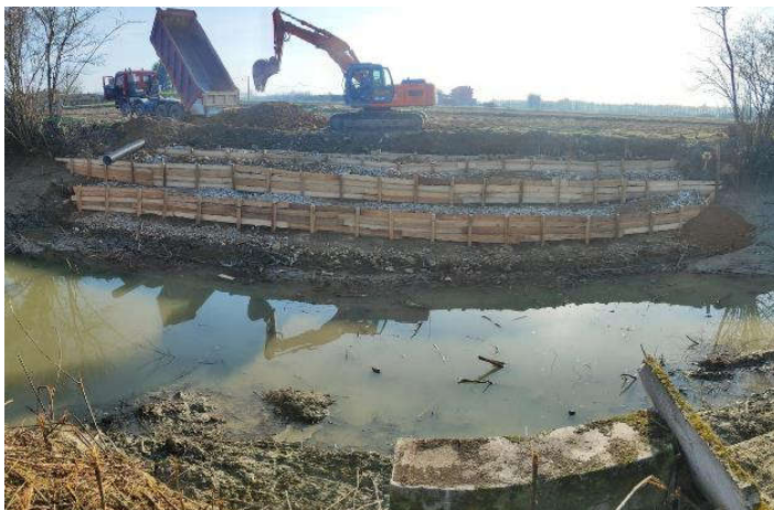
3. Intervento di risanamento sponda DX del Naviglio d'Ivrea, a seguito di frana, a monte dell'abitato di Borgomasino - €12.000
