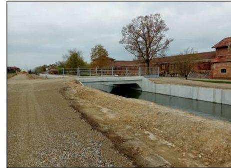
Realizzato: Naviletto di Saluggia e ponte 12 Colombara (I stagione)
