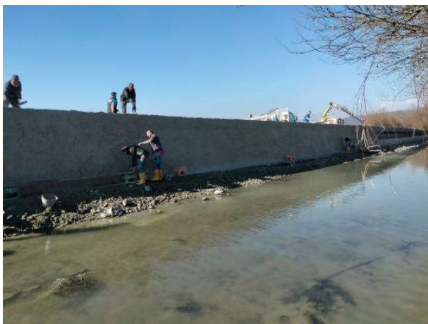
1. Risanamento muri del Naviglio d'Ivrea, sponda DX, in Comune di Borgomasino per m. 230.00 - € 24.000
