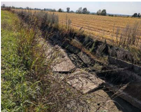
1. Cavo Formica in comune di Prarolo rifacimento tratto di rivestimento in sponda sx per ml 50 con pannelli prefabbricati € 25.000
