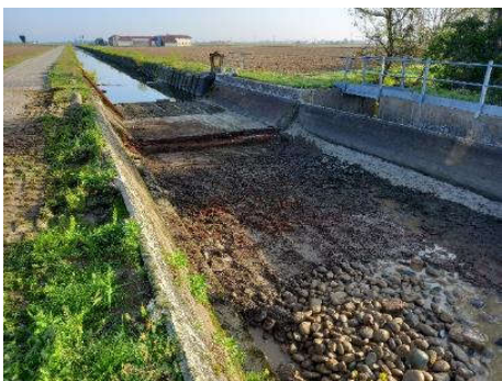
2. Roggia Molinara di Larizzate in comune di Vercelli ristrutturazione sezione idraulica pontecanale sulla Roggia Vassalla € 65.000
