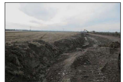
Lavori in corso: Naviletto di Saluggia demolizione rivestimenti tratto tra ponte 5 e ponte 7 (II stagione)
