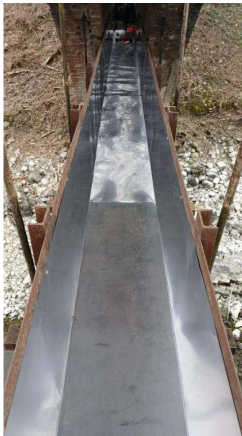
7. Rivestimento di n. 1 ponticanale sul c. Depretis mediante fornitura e posa di profilati in acciaio inox sagomati e incassati all'interno delle canalette in ferro deteriorate, nei comuni di Saluggia e Cigliano. €5.000
